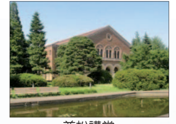
兼松講堂 昭和2年建設。兼松商店の寄付による今も現役のホールです。
