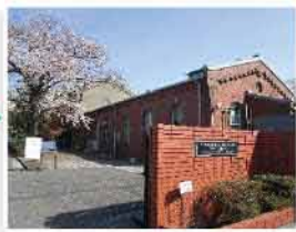
旧醸造試験所第一工場
