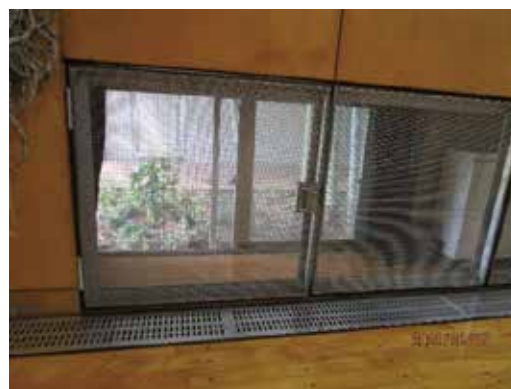
図5 体育館側面の窓の様子
