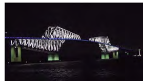
<東京ゲートブリッジ>
