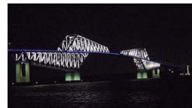
<東京ゲートブリッジ>
