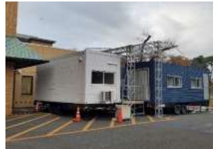
多摩北部医療センターに設置したトレーラーハウス
