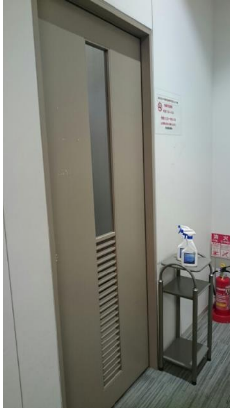
開閉時に空気の乱れの少ないスライド式ドア
