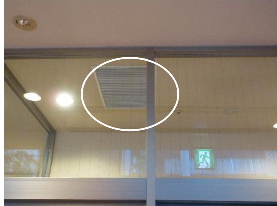
屋外への排気口 シロッコファンに よって屋外に排気
