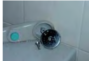
シャワーヘッドを分解したところ
