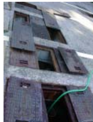
ばっ気槽清掃中
