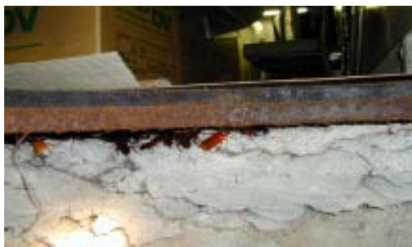
排水槽マンホール部分に生息するゴキブリ
