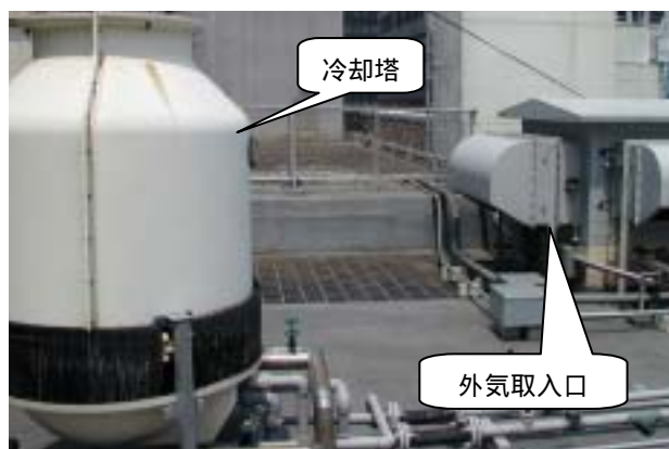
冷却塔と近接している例
