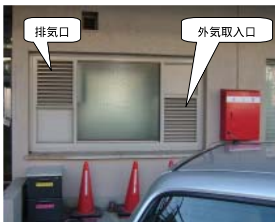
駐車場の横で排気口と近接した例
