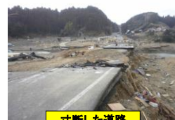
寸断した道路
