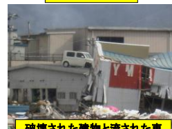
破壊された建物と流された車
