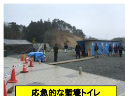
応急的な暫壕トイレ
